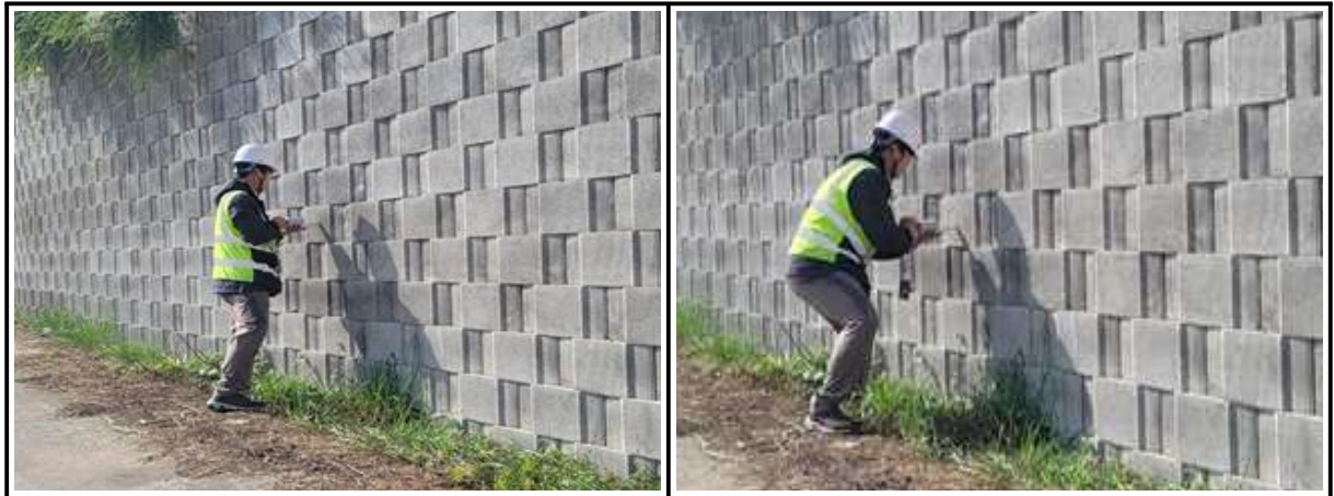
【그림 3.3.6】 슈미트해머를 이용한 반발경도시험 전경
